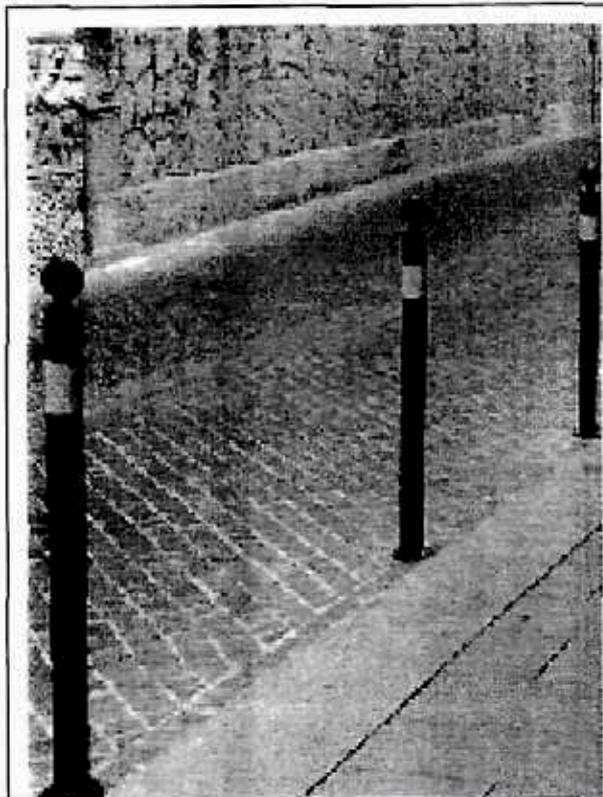
Dissuasore costituito da supporto verticale in metallo di colore scuro, del diametro di 80 mm con sovrastante elemento decorativo in metallo massiccio a forma sferica. Può essere fornito di alette laterali idonee per l'applicazione di catena
